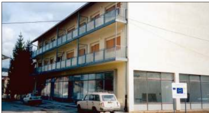
ASB/EC je obnovio stambenu zgradu "Partizanska" u naselju Donji Srb, općina Gracac koja ima 8 stanova. U ovaj projekt uključena je obnova dvije trgovine u prizemlju zgrade te priključenje vode, kanalizacije i struje. Osam bivših nosioca stanarskog prava vratilo se u ove obnovljene stanove.
